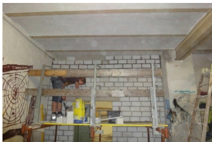
Die Mauer ist fast fertig
